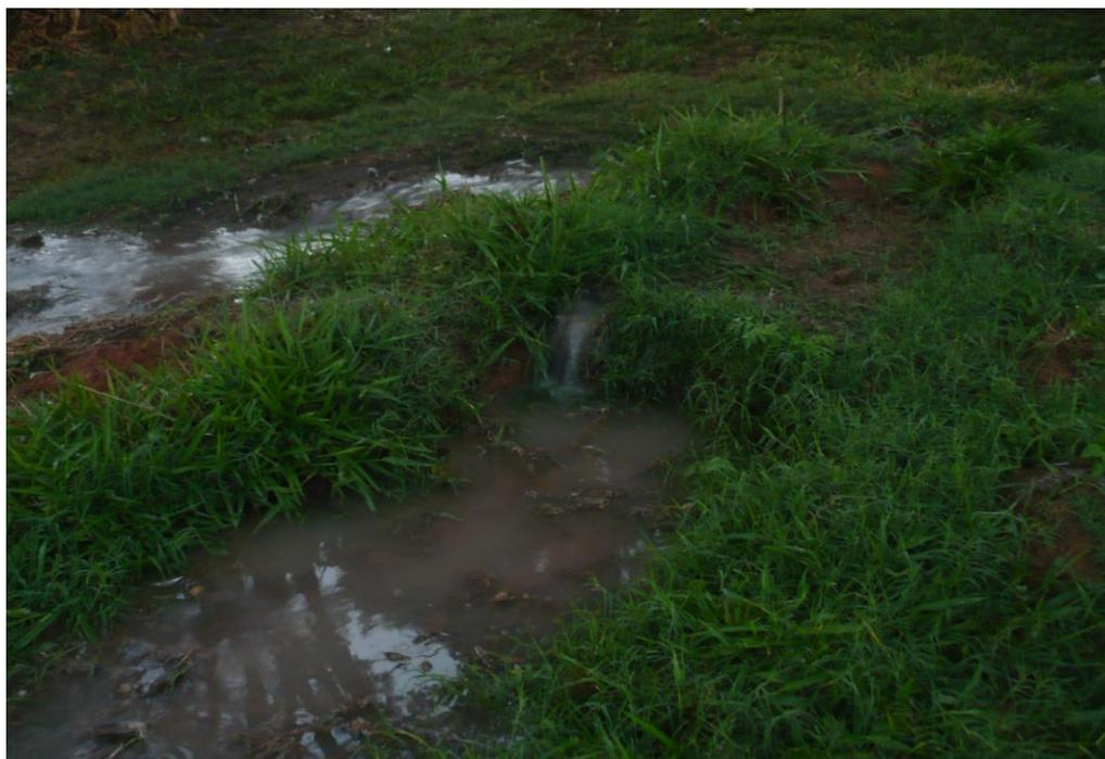
**Figura 10 – Vazamento na rede de esgoto do SAAE, no dia 28/07/09 após uma chuva fraca na cidade. Organizado por Vinícius de Souza Soares Guerra, 2009.**
